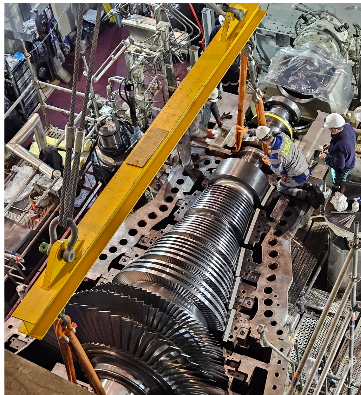
Trabajos de mantenimiento en planta termosolar Astexol-2, España.
