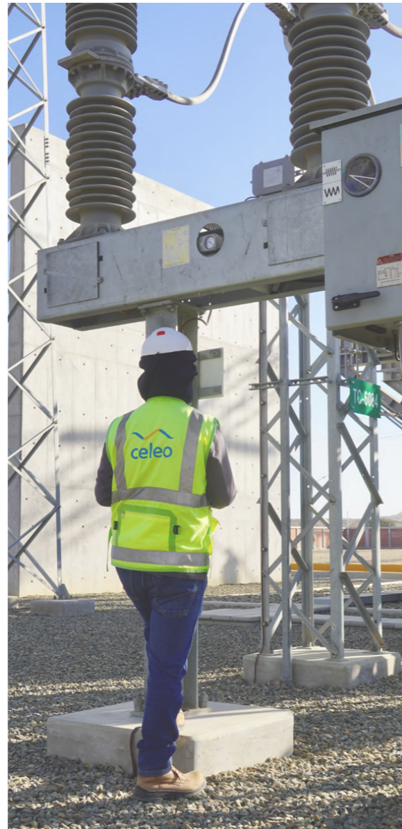
Trabajos de mantenimiento en la subestación de Valle del Chira, Perú.
