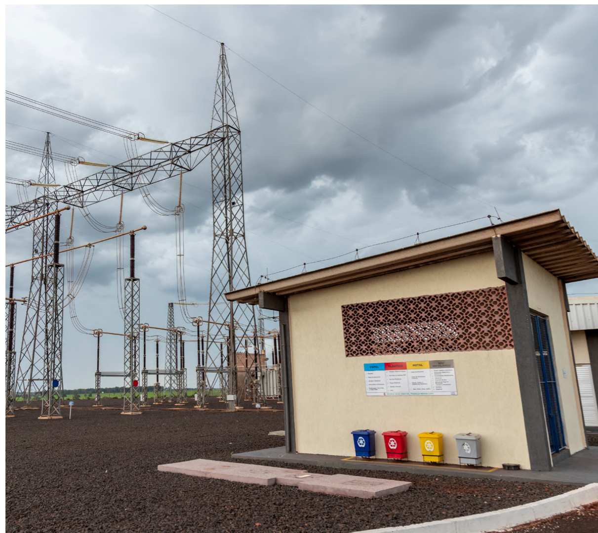
Segregación de residuos en la subestación Itaguaçu de la línea de transmisión Coqueiros.
