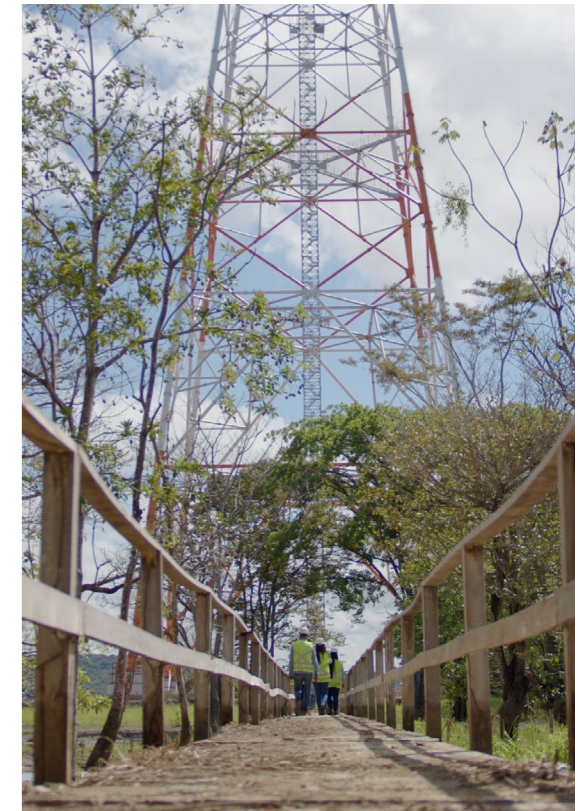
Inspección en la torre de travessía do Rio Amazonas, PATE
