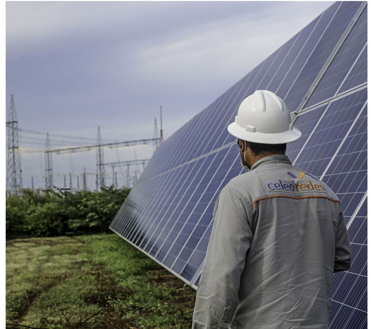
Inspección en UFV São João do Piauí
