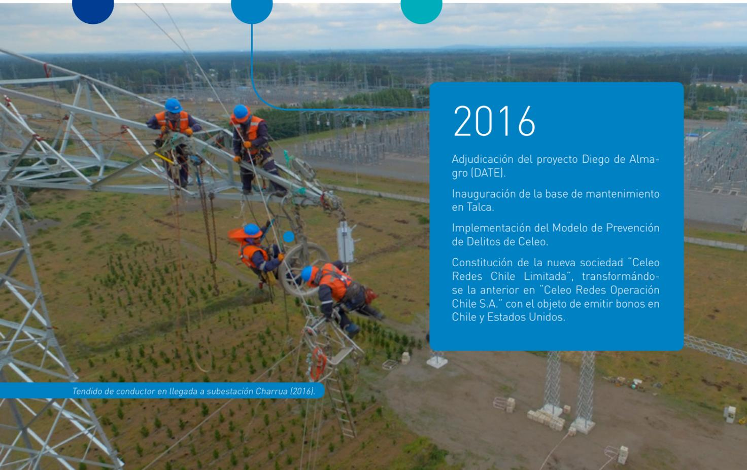
Tendido de conductor en llegada a subestación Charrúa (2016).
