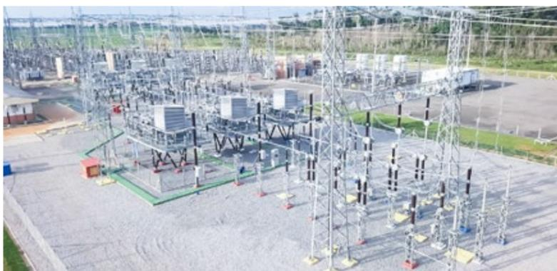
Ainda em 2017, foi iniciada a obra de reforço na Pedras Transmissora de Energia (PTE) com a instalação do terceiro banco de autotransformadores 345-138kV 3x133MVA na Subestação Venda das Pedras.
