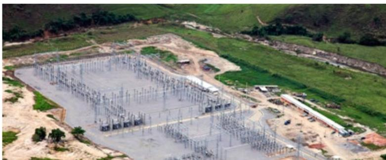
Alguns projetos de reforços mereceram destaque durante o ano. Em janeiro de 2017, entrou em operação comercial antecipada o Reforço da Linha de Transmissão Corumbá (LTC), com a instalação de um reator de barra de 230kV e módulos associados na Subestação Corumbá 2. A função deste Reforço é auxiliar no controle de tensão do sistema da região.
